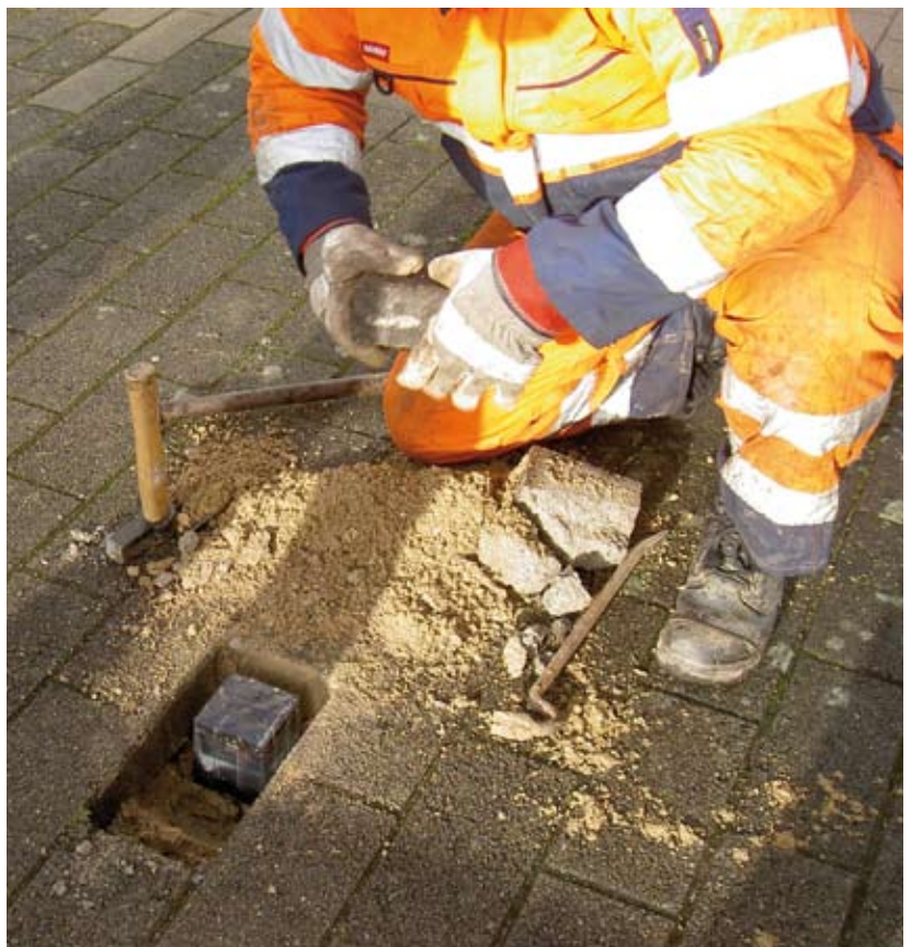
Som led i gennemførelsen af Albertslund Kommunes belysningsplan blev der også installeret ledelys i form af LED-forsynede chausséstøen med solcelledrevet elforsyning.
